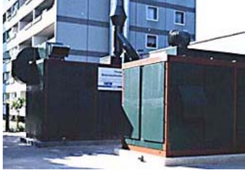
Cella combustibile di una centrale a cogenerazione (Amburgo)
