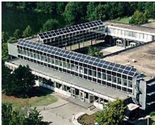
Progetto PHOEBUS – Centro di ricerca Jülich (Germania) Combinazione fotovoltaica – elettrolisi - cella a combustibile. Impianto dimostrativo per l'approvvigionamento autonomo con energie rinnovabili
