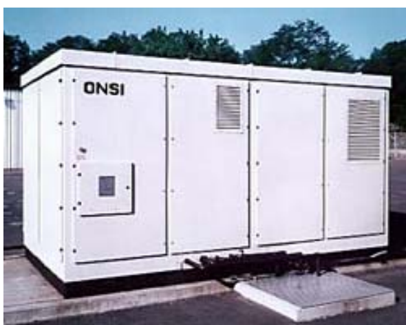
Centrale di cogenerazione alimentata con gas metano con cella a combustibile e una pompa di calore ad assorbimento
